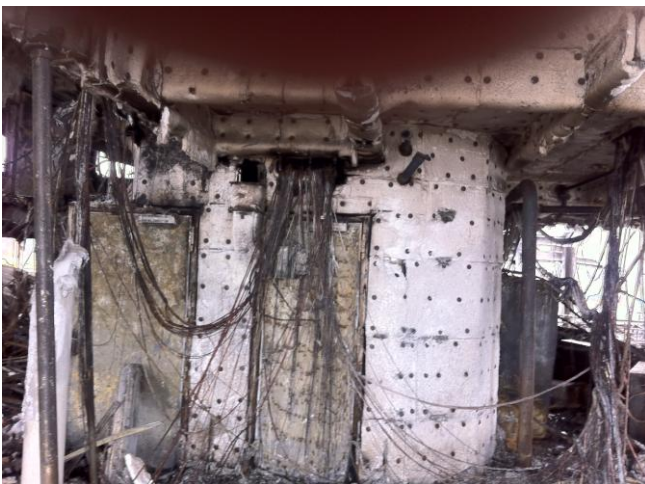
Εικόνες 4.1.2/3 & 4: Χαρακτηριστικές εικόνες της κατάστασης στην οποία βρέθηκαν οι καλωδιώσεις του ηλεκτρικού δικτύου εντός του χώρου όπου αναπτύχθηκε η πυρκαγιά.
