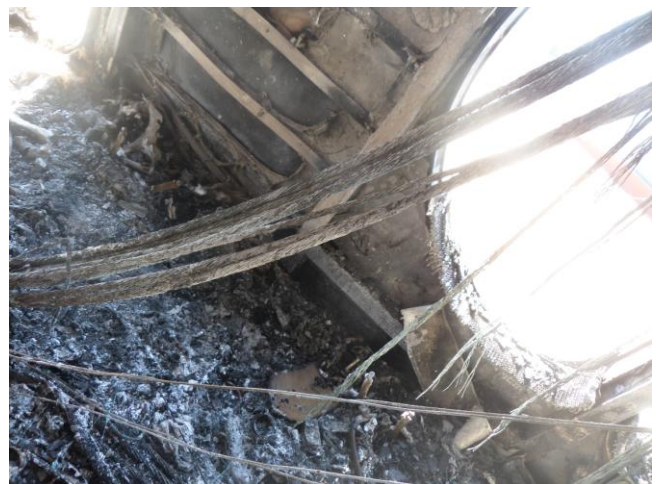
Εικόνες 4.1.2/3 & 4: Χαρακτηριστικές εικόνες της κατάστασης στην οποία βρέθηκαν οι καλωδιώσεις του ηλεκτρικού δικτύου εντός του χώρου όπου αναπτύχθηκε η πυρκαγιά.
