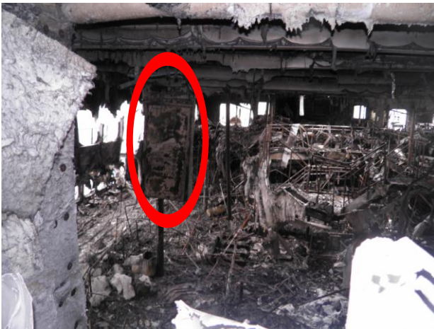
Εικόνες 4.1.1/5 & 6: Άποψη της οροφής των χώρων άνωθεν του καταστρώματος «Upper Deck» και του καταστρώματος «Bridge Deck» κοιτώντας από τη Γέφυρα Ναυσιπλοΐας προς την πρύμνη. Από τη θέση του κατώτατου τμήματος των δύο θυρών επί του Νομέα 31 που αιωρούνταν, γίνεται αντιληπτή η θέση στην οποία υπήρχε το κατάστρωμα «Bridge Deck» πριν από την πλήρη κατάρρευσή του λόγω της πυρκαγιάς.
