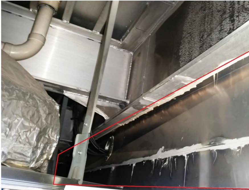
Εικόνα 4.5/1: Άποψη τμήματος (σε πλαίσιο κόκκινου χρώματος) χωρίσματος «draught stop» εντός του χώρου άνωθεν της ψευδοροφής του «ΧΑΪΣΠΙΝΤ 4», κατασκευής παρόμοιας με τα αντίστοιχα που ήταν τοποθετημένα στο «ΧΑΪΣΠΙΝΤ 5».
